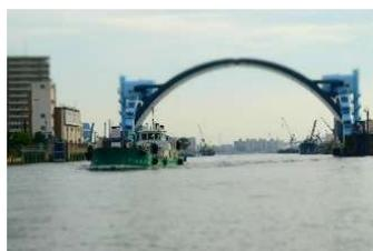
続いて大阪湾の3大水門の一つ尻無川のアーチ型水門を通過し、幅12m、重さ530tという強大さに感心し、今年の台風21号の際に閉めた時は、水門の上下で3mの水位の違いがあったということである。尻無川・安治川・木津川の水門は、高潮に対する防潮水門だが、地震により発生する津波に関しては、地震で機械の動作に支障があつて、動かない場合はどうなるのか、閉まったままでは、河川の水位が上がり、内陸部に越水した場合の対策は等が話題になった。
